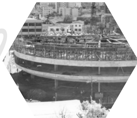
Construção da Procergs Acervo Procergs
